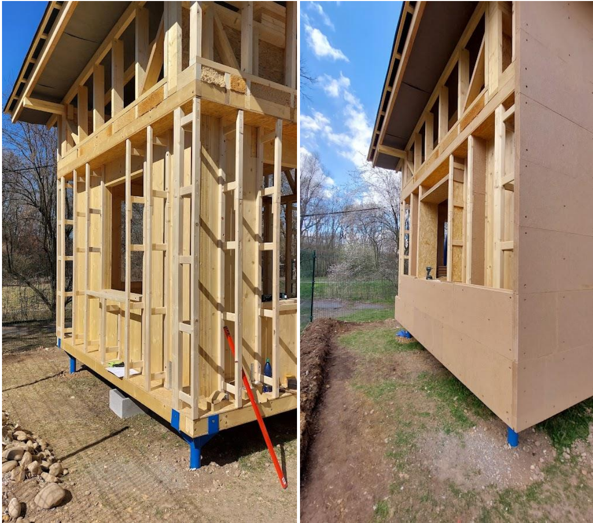
Obrázok 25. Montáž rebríkových nosníkov na MHM bloky a obkladanie fasádnou izoláciou. (foto: P. Štompf).
