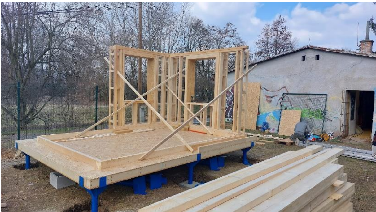
Obrázok 13. Montáž obvodových stien z vyľahčených nosníkov. (foto: P. Štompf).
