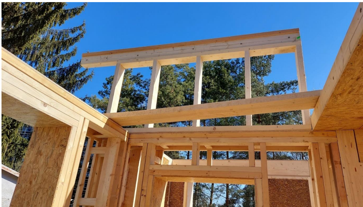
Obrázok 21. Realizácia nadstavby objektu – rámová konštrukcia s pomúrniceou. (foto: P. Štompf).
