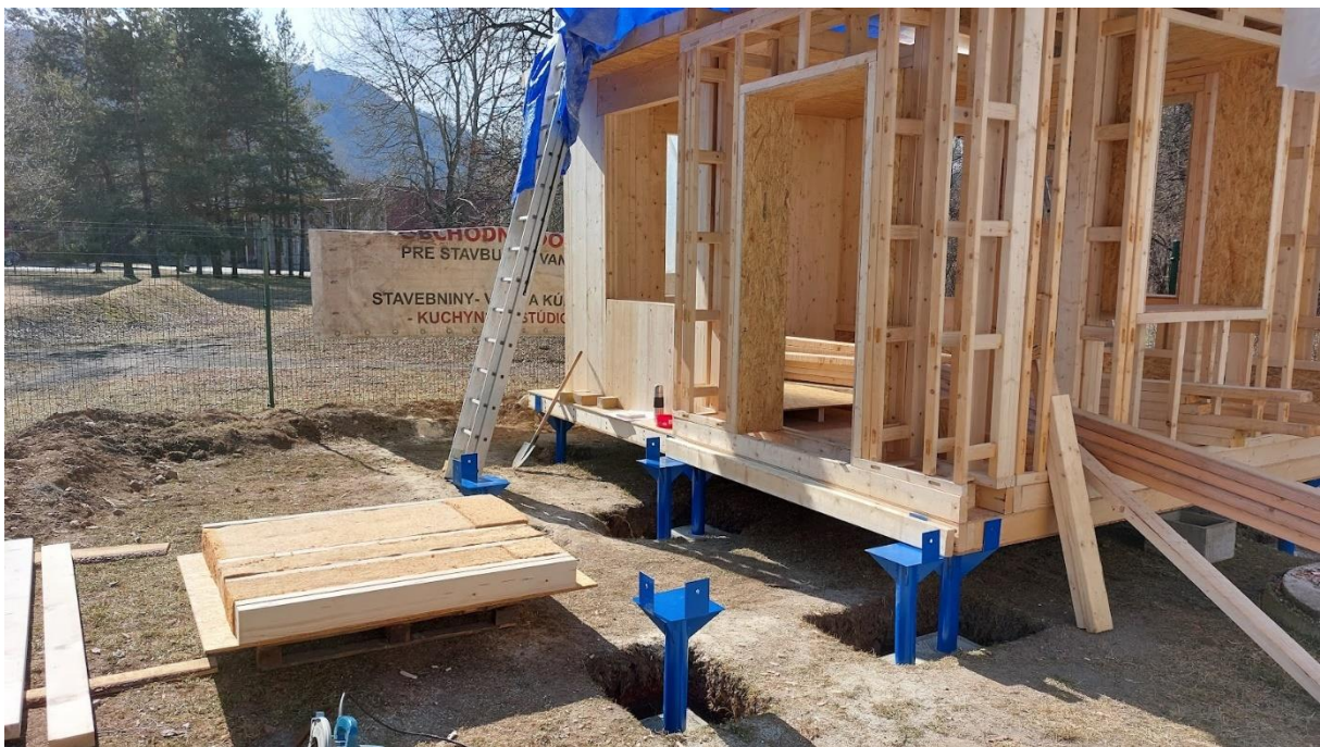
Obrázok 16. Montáž podlahových panelov v časti zádveria. (foto: P. Štopf).
