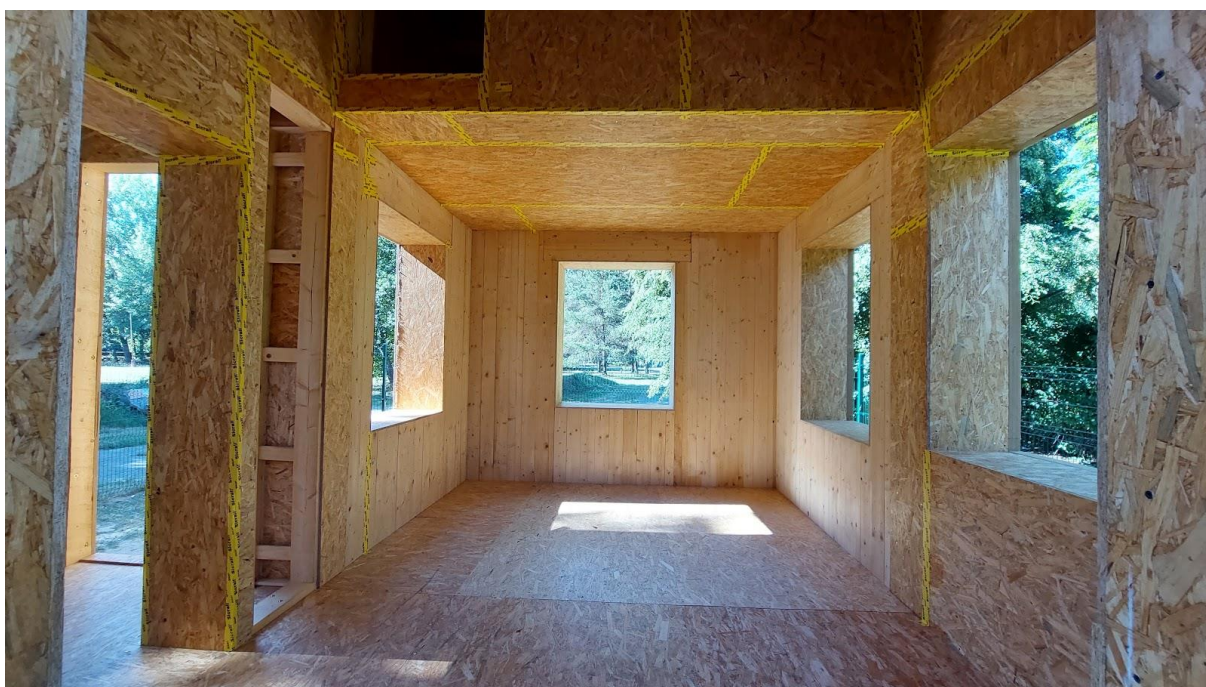
Obrázok 28. Hrubá stavba výskumného objektu z interiéru. (foto: P. Štopf).
