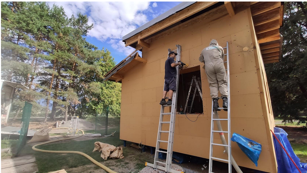
Obrázok 29. Aplikácia fúkaných tepelných izolácií: slamy, korku, drevovlákna, celulózy a minerálnej izolácie. (foto: R. Uhrín).
