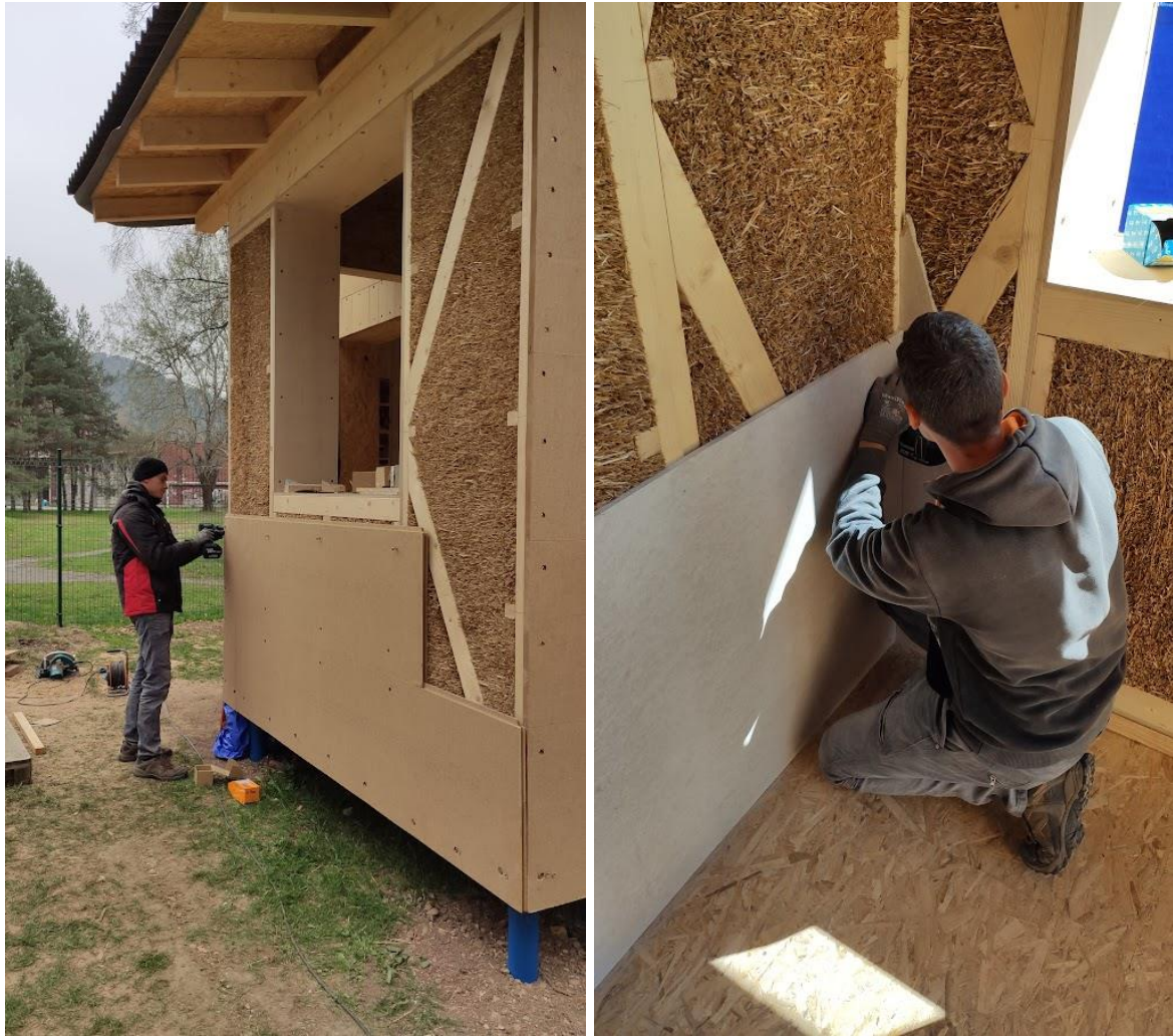
Obrázok 26. Obkladanie panelov EcoCocon z vonkajšej a vnútornej strany. (foto: R. Uhrín).
