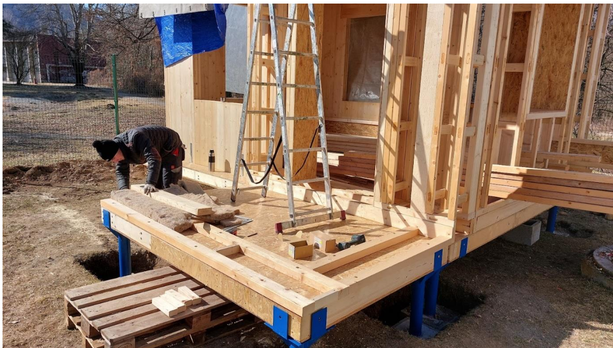
Obrázok 17. Príprava základových prahov pod systém EcoCocon. (foto: P. Štompf).
