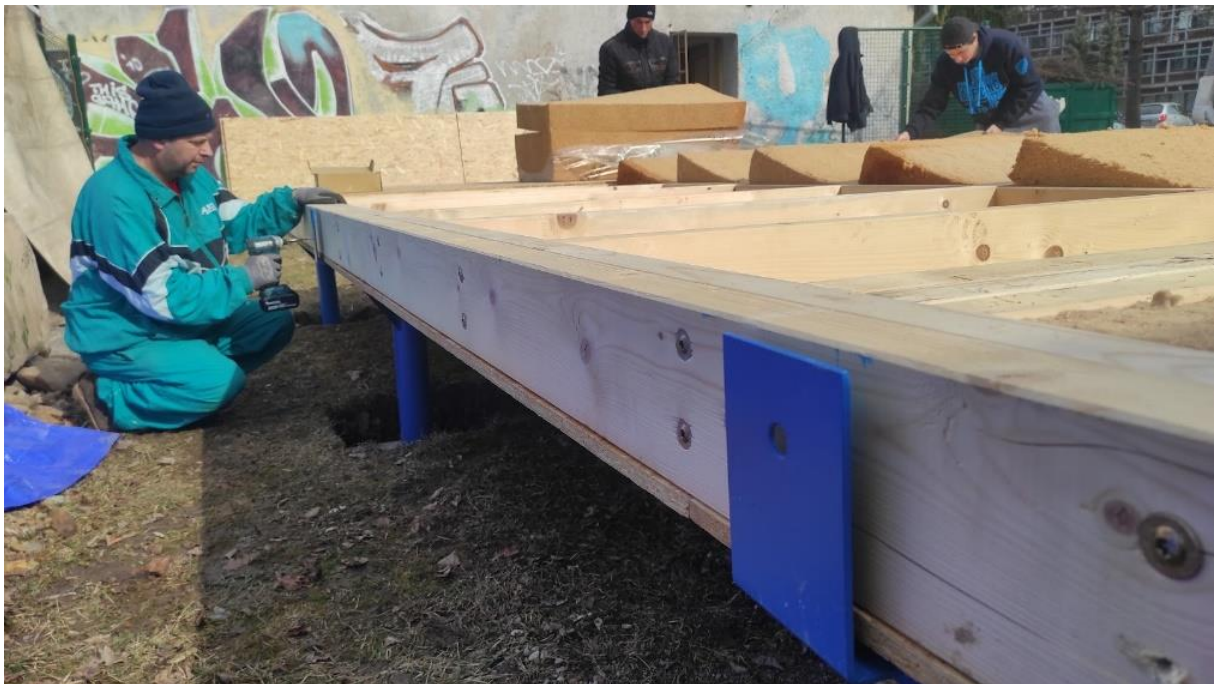
Obrázok 10. Montáž predpripravených podlahových panelov. (foto: P. Štompf).
