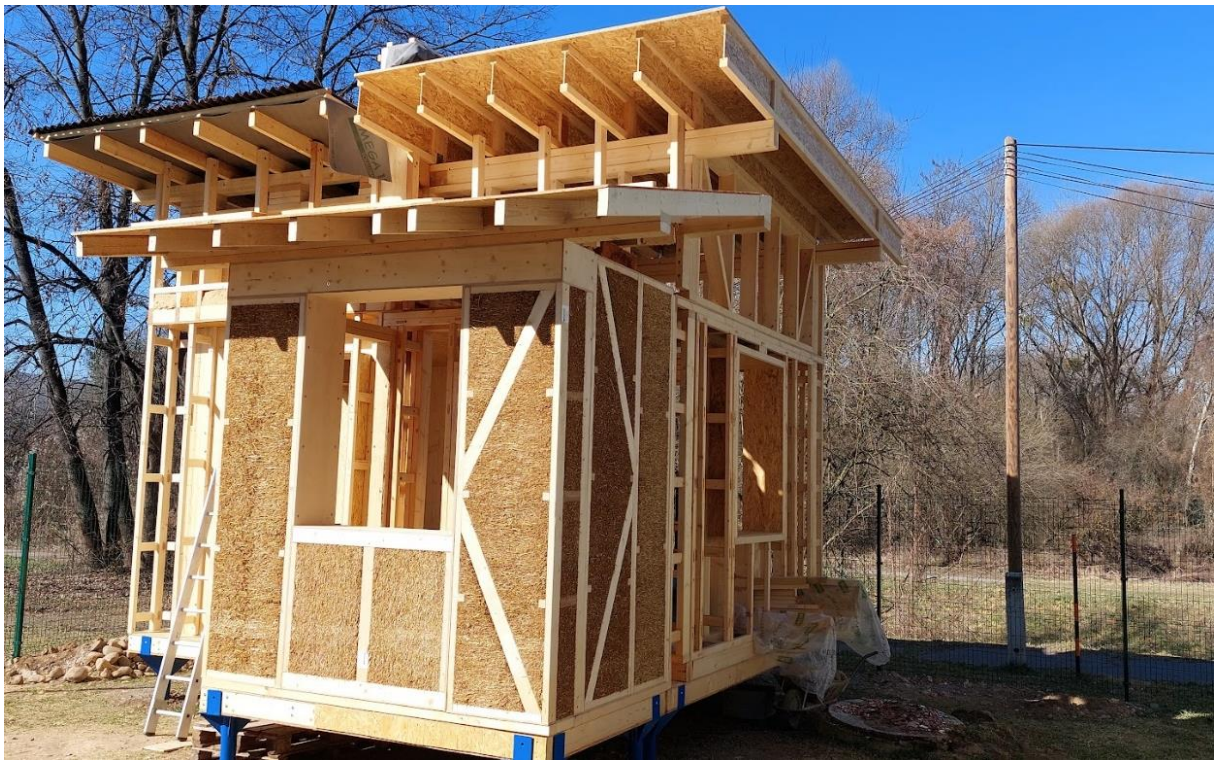
Obrázok 24. Realizácia šikmej strechy v časti zádveria – hrubá konštrukcia. (foto: P. Štopf).
