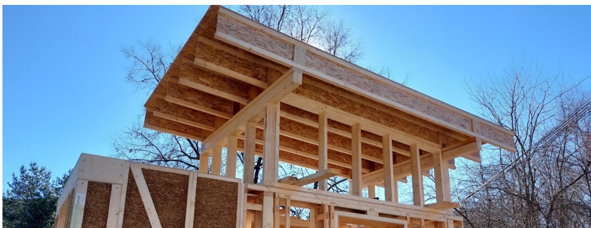
Obrázok 22. Hrubá konštrukcia plochej strechy z I-nosníkov. (foto: P. Štompf, R. Uhrín).
