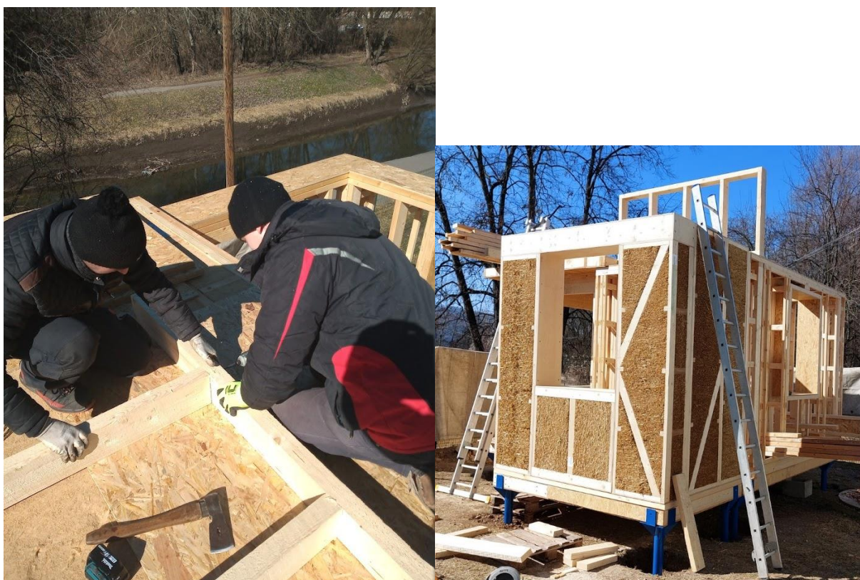
Obrázok 20. Realizácia nadstavby objektu – výroba rámovej konštrukcie na mieste stavby. (foto: S. Jochim).
