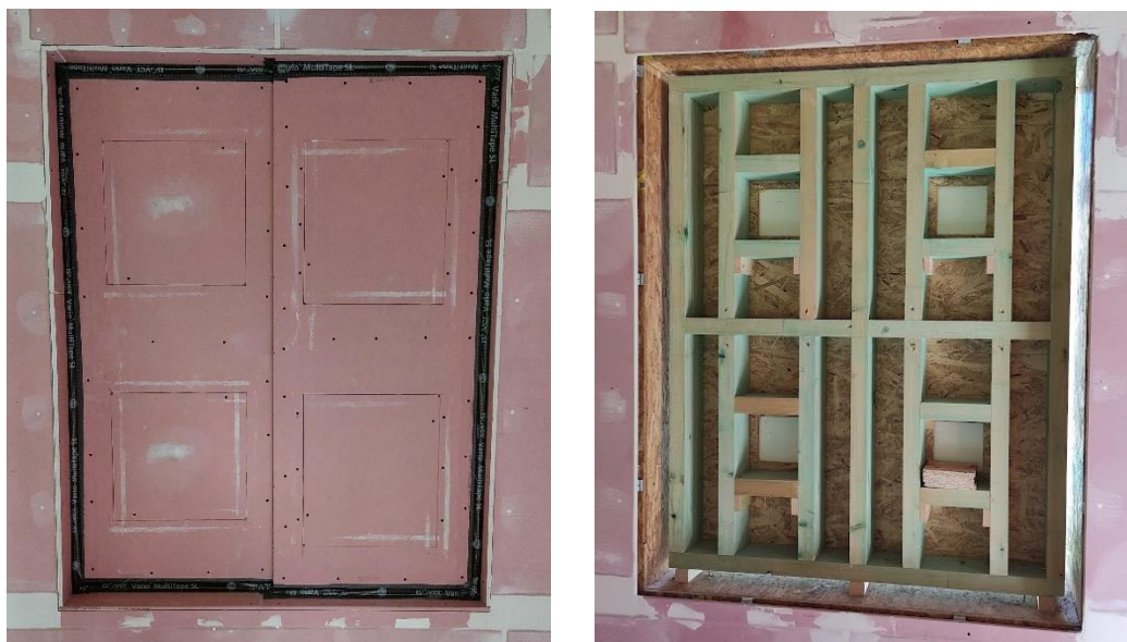
Obrázok 7. Výskumné otvory vyplnené fragmentmi konštrukcie obvodových stien. (foto: P. Štopf, R. Uhrín).
