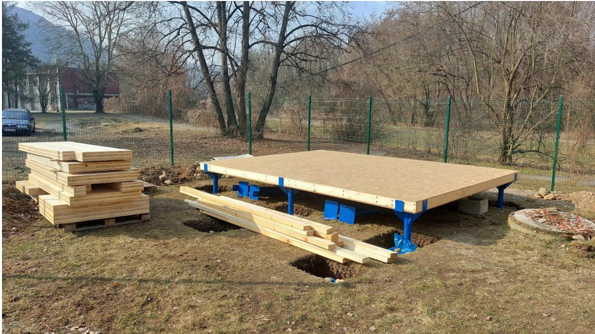
Obrázok 11. Príprava montáže obvodových stien z MHM blokov a rebríkových nosníkov. (foto: P Štompf).
