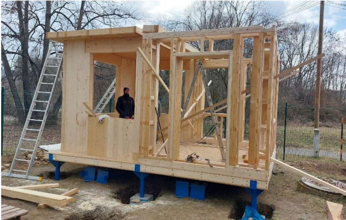
Obrázok 15. Montáž stropných panelov. (foto: P. Štopf).
