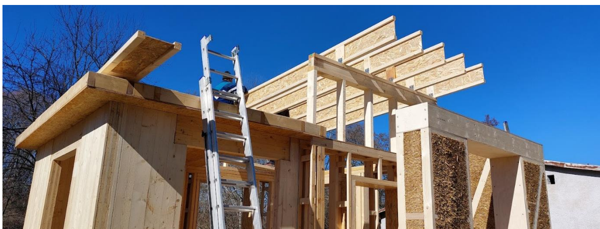
Obrázok 21. Realizácia nadstavby objektu – rámová konštrukcia s pomúrniceou. (foto: P. Štompf).
