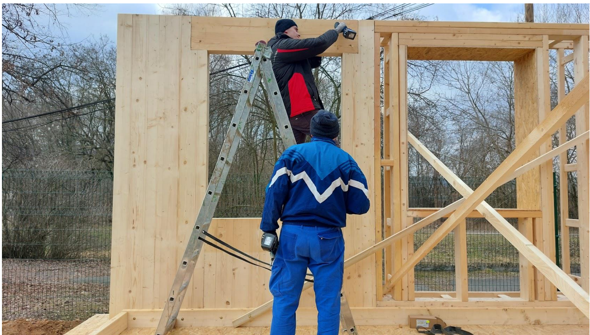
Obrázok 14. Montáž obvodových stien z MHM blokov. (foto: P. Štompf, R. Uhrín).
