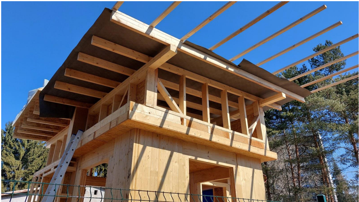
Obrázok 23. Realizácia šikmej strechy v druhej časti objektu. (foto: P. Štompf).
