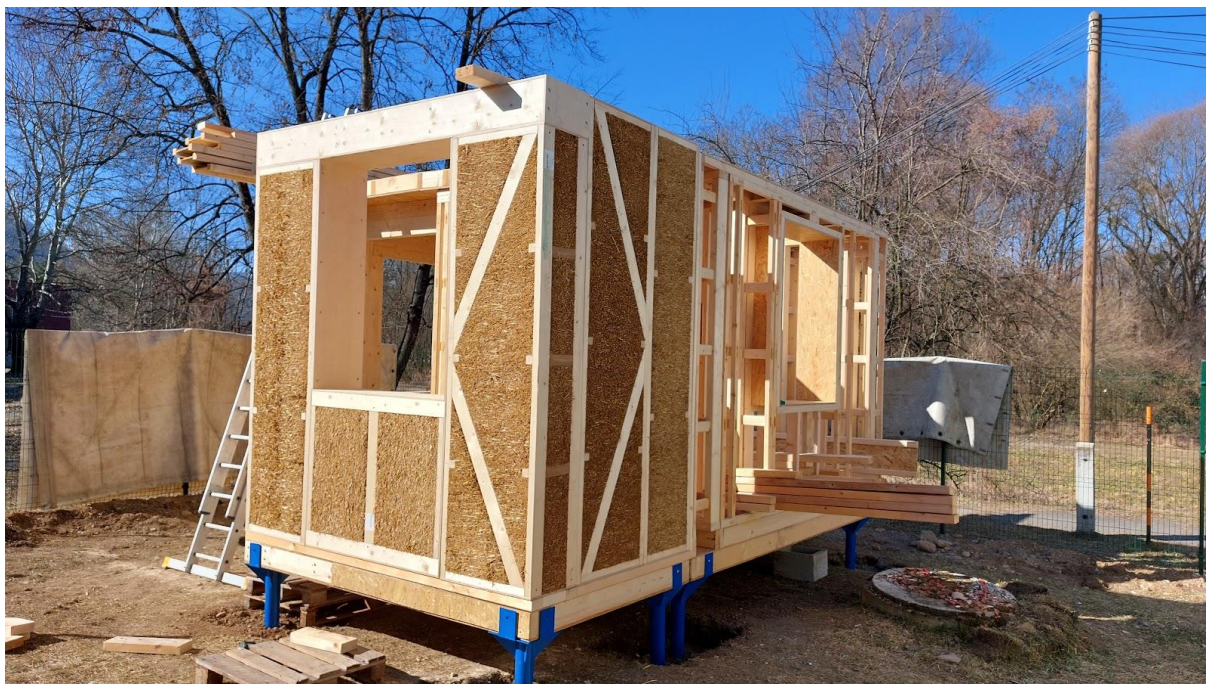
Obrázok 19. Príprava pred realizáciou vrchnej nadstavby a strechy objektu. (foto: P. Štompf).
