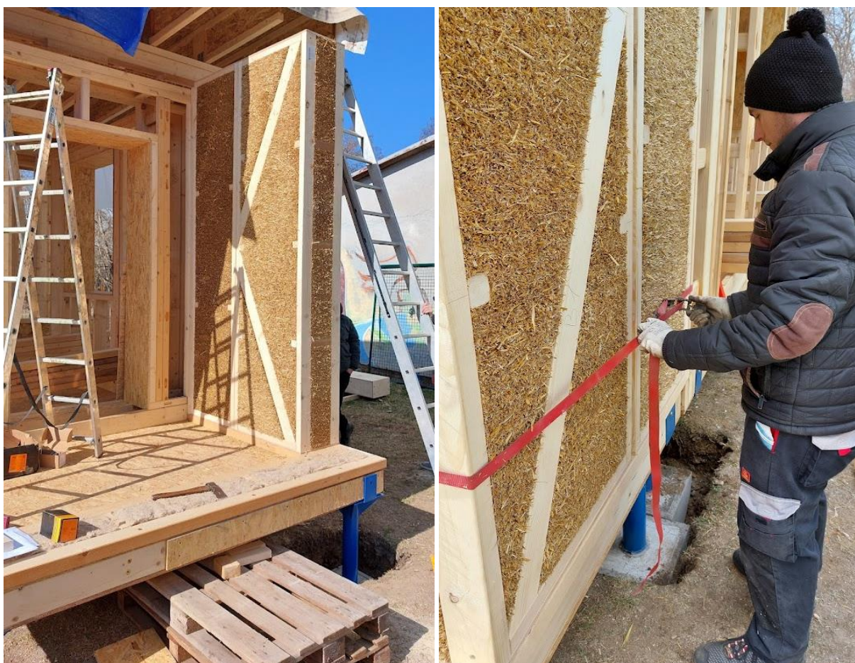
Obrázok 18. Montáž panelov obvodových stien zádveria – systém EcoCocon. (foto: P. Štompf).
